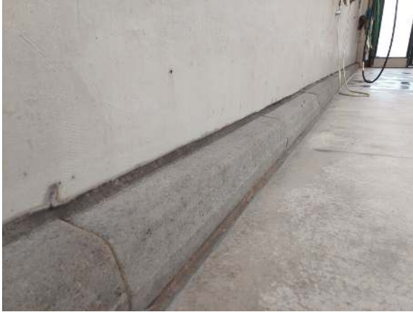
106. Pesuhallin lattia- ja seinäpintoja.
