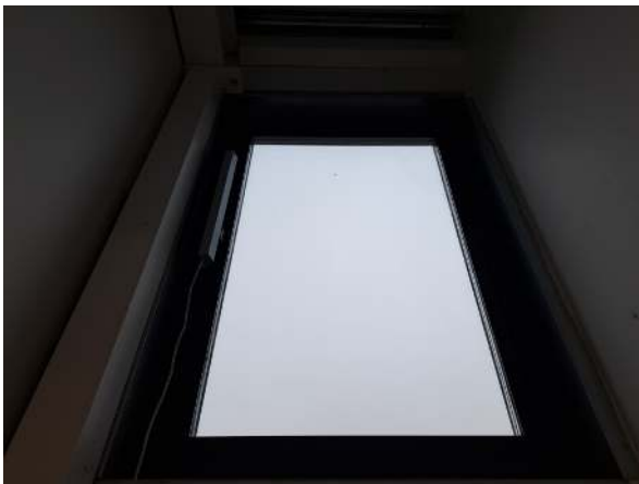
186. Savunpoistojärjestelmän ikkuna.
