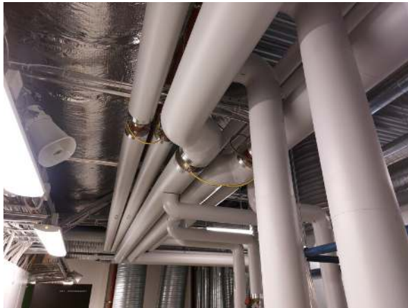
117. Lämpöjohtojen eristystä.
