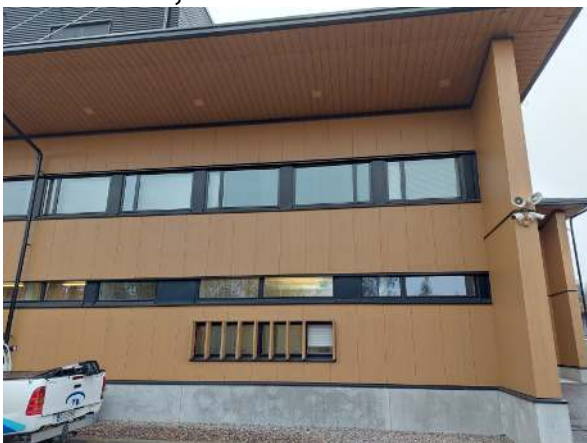
50. Julkisivun levyrakenteita ja puurakenteisia räystäsrakenteita.
