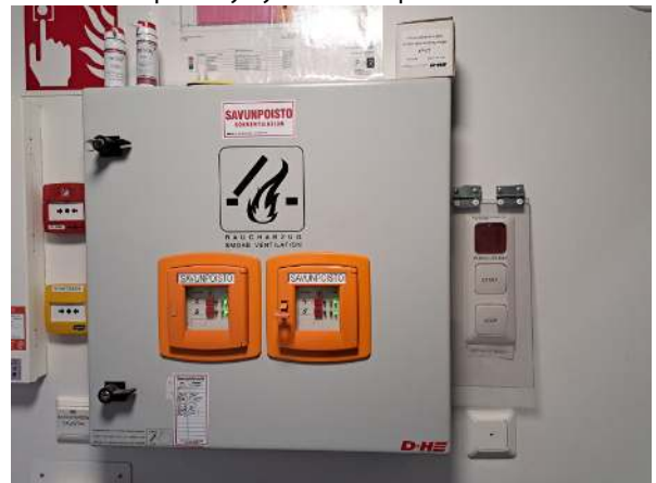
187. Savunpoistojärjestelmän keskus.
