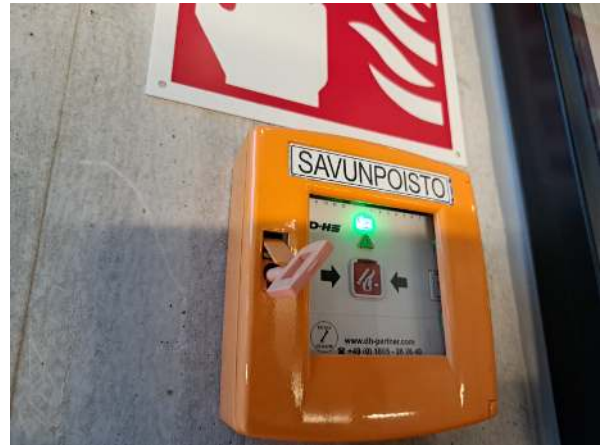
185. Savunpoistojärjestelmän painike.
