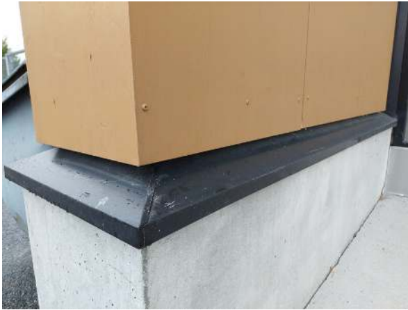
52. Julkisivun alareunan pellitystä.
