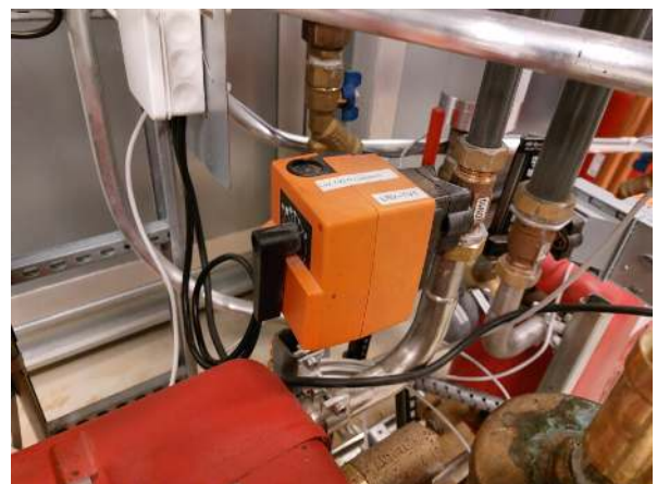
113. Säätöventtiili.
