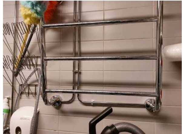
119. Käyttövesipatteri.
