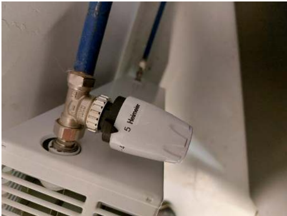
114. Termostaattinen patteriventtiili.
