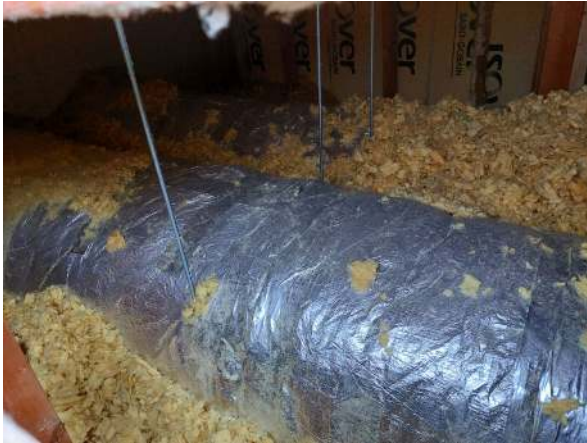
140. IV-eristystä yläpohjatilassa.
