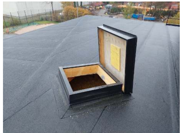
84. Käyntiluukku yläpohjaan.
