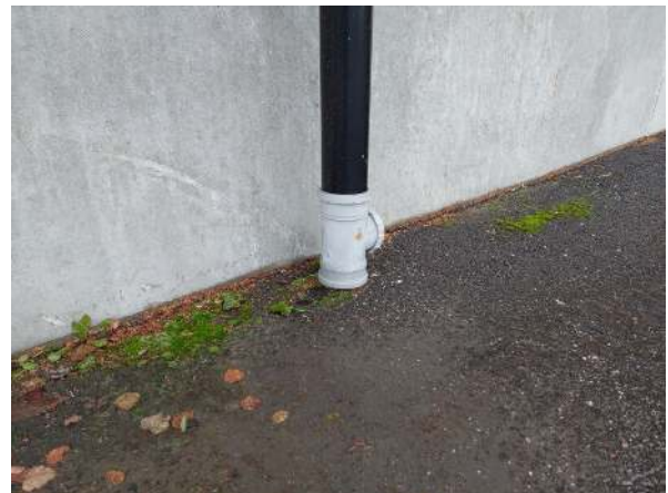
6. Kattovesien ohjausta sadevesijärjestelmään.
