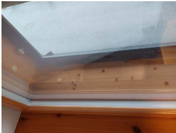
56. Ikkunat ovat MSE-AL -tyyppiset. Ulkopinnat ovat alumiinia.
