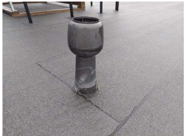
78. Yläpohjan tuuletusputkia.
