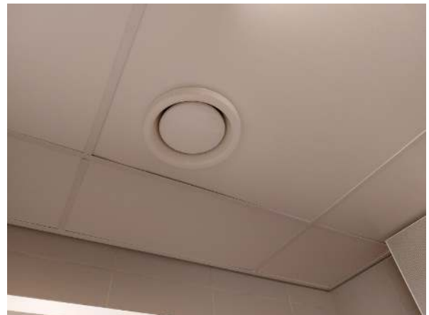
139. Poistoilmaventtiili.
